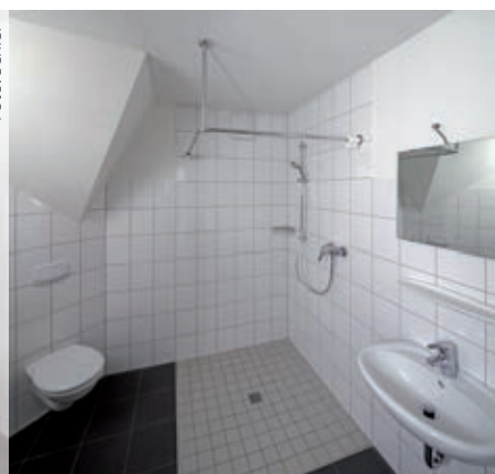
Die Toiletten werden in allen 23 Wohnungen mit Betriebswasser aus einer zentralen Grauwasseranlage gespült
