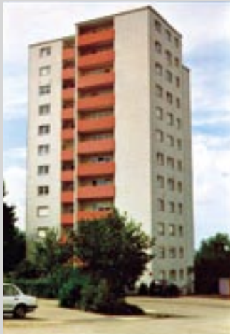
Nachrüstung einer Rauch-Verdrängungs-Anlage am Beispiel eines Wohnhauses in Eppingen/Württemberg.
