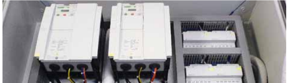
Frequenzumrichter DF6 ermöglichen eine wirtschaftliche Drehzahlregelung der Ventilatoren.
